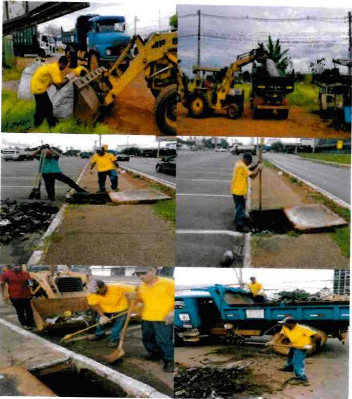
Serviços executados pela equipe da Administração Regional do SIA (Setor de Cargas e Inflamáveis).
